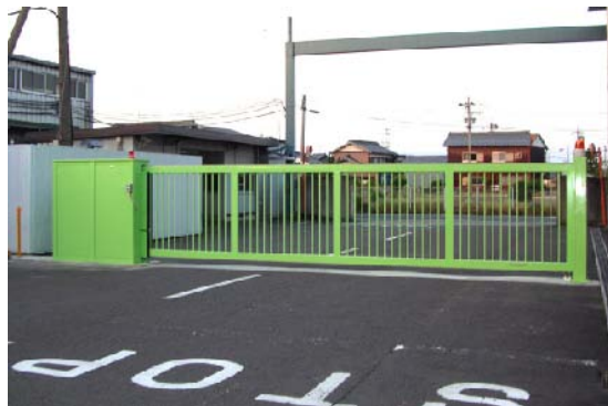
●レール引き戸タイプ 材質：鉄 設置場所：工場搬入門
