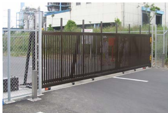
●既存門扉に駆動装置を取付けることでオートゲート化 設置場所：工場出入り口
