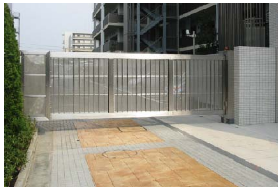
●ノンレール引き戸タイプ 材質：ステンレス 設置場所：マンション駐車場出入り口
